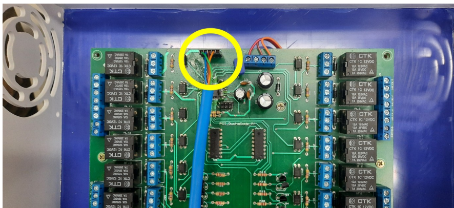
Figura 4: Soltando o cabo de comunicação
